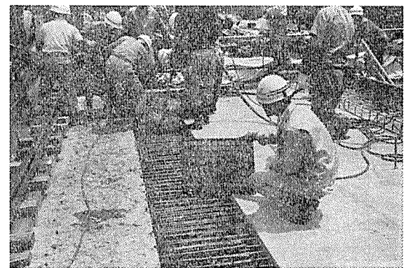
写真-6 二次床版コンクリート打設
