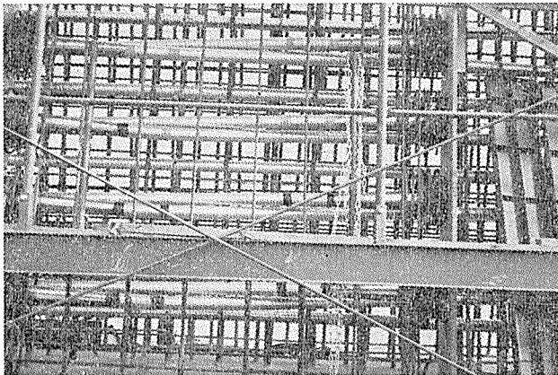
写真-4 鉄筋および PC 鋼材の配置
