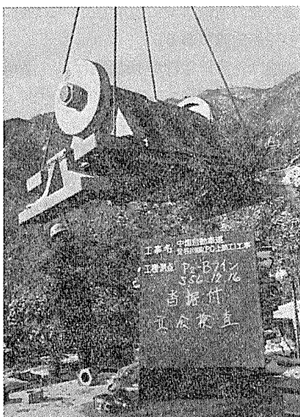
写真一2 支承設置状況
