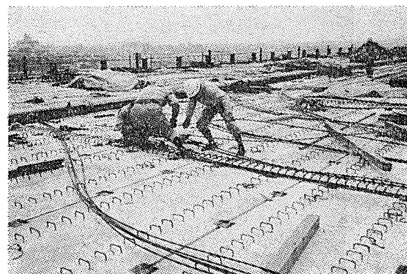
連続ケーブル挿入中
