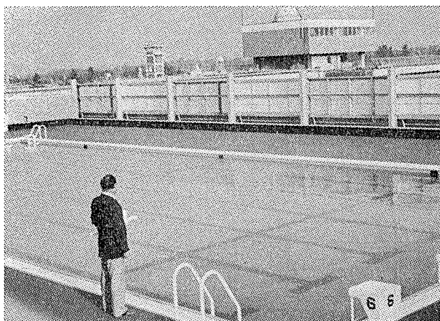
写真-4 屋上プール
