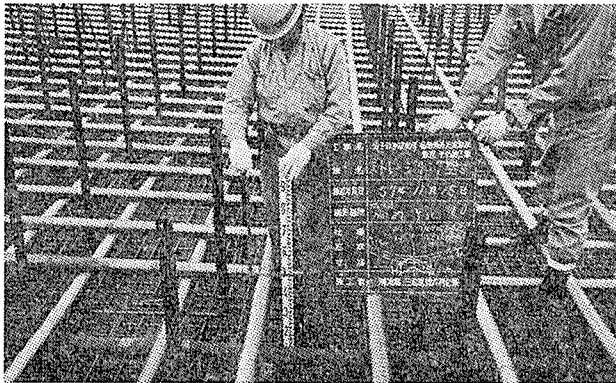
写真—3 無梁版部ケーブル組立て—1
