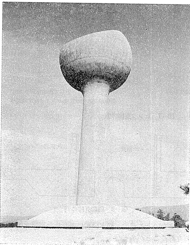
写真—3 瀬戸市にある配水池
