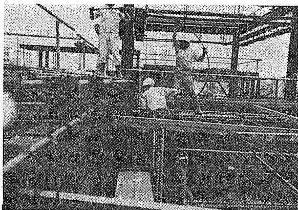
写真—2 PC 鋼線の配線作業
