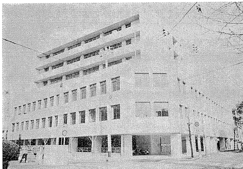
写真-1 完成写真
