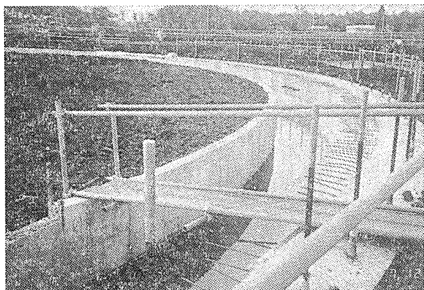
写真—4 基礎コンクリート打設完了 PC 鋼棒が埋め込まれている。 鋼棒の頭部は養生キャップ。
