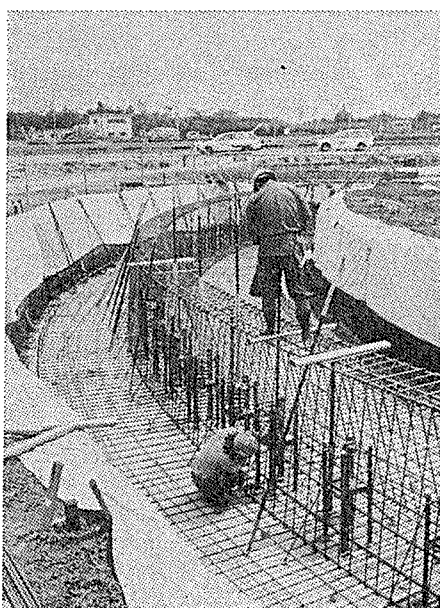
写真-2 根伐後の基礎の配筋
