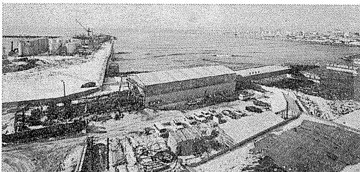
写真-2 ヤード全景 (冬季)
