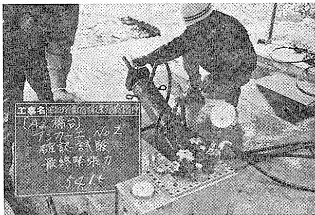
写真-2 ロックアンカー工の確認試験
