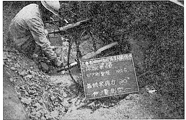
写真—7 吊 PC ケーブルの緊張
