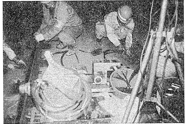
写真—2 可変パッドへのポリモルタル注入
