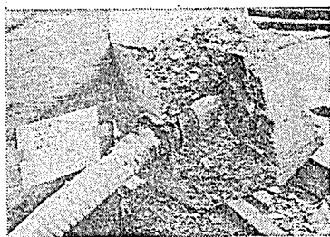
写真-1 定着部付近の空隙
