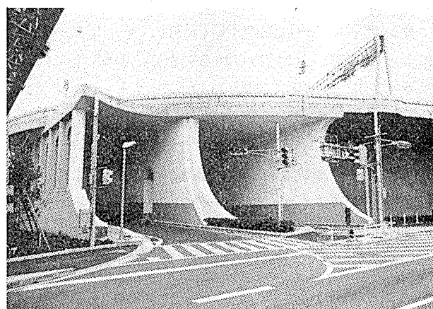
写真—15 ランプ出入口部
