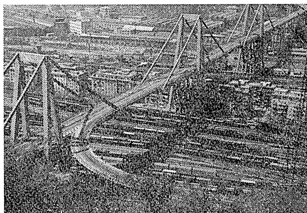
写真—16 ポルチェベラ橋
