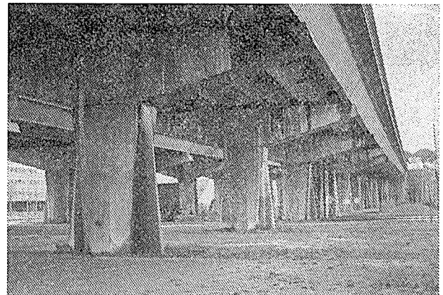
写真—24 フランチア高架橋
