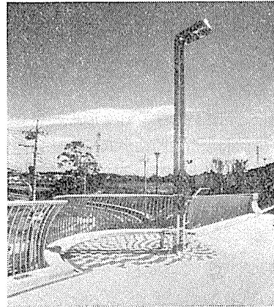
写真—24 多 2・2・6—1 号橋
