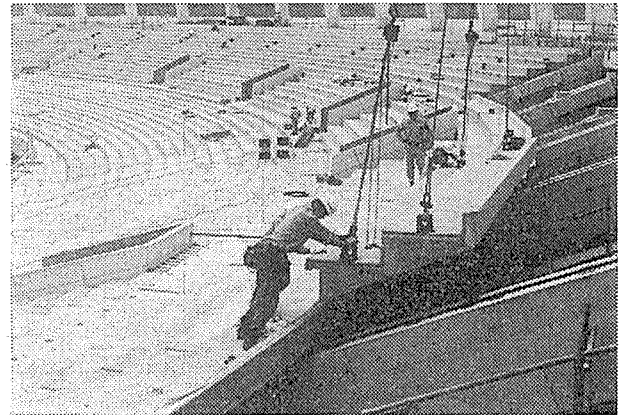
写真-8 PC段床架設
