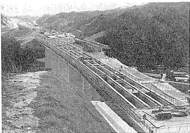
写真-3 主桁架設全景
