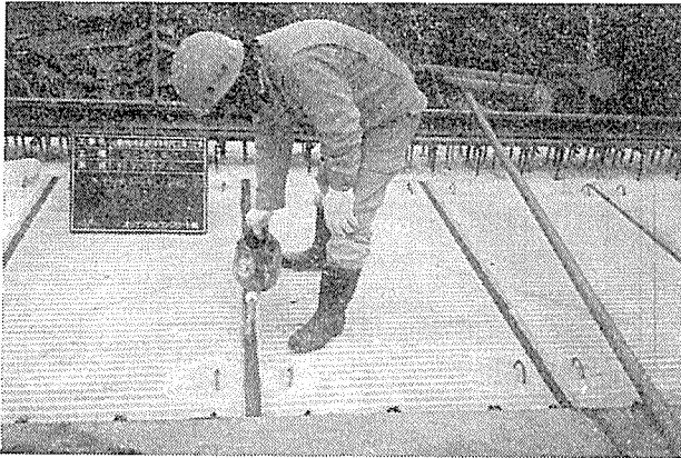
写真—12 継目部無収縮モルタル打設
