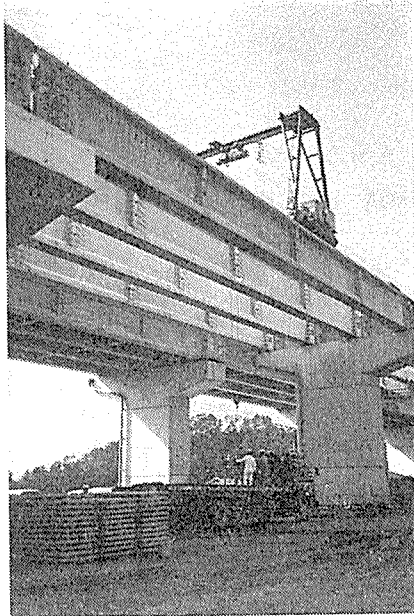
写真—9 PC 版の吊上げ
