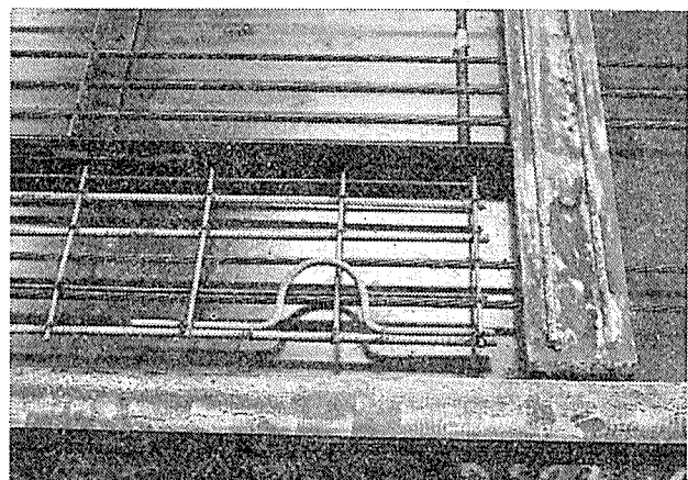
写真-2 吊り金具 (凹凸成形後に起こす)
