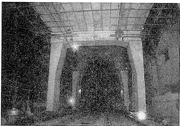
写真—13 直上高架橋完成
