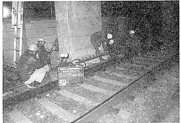
写真-9 脚柱下端部の PC 鋼棒緊張
