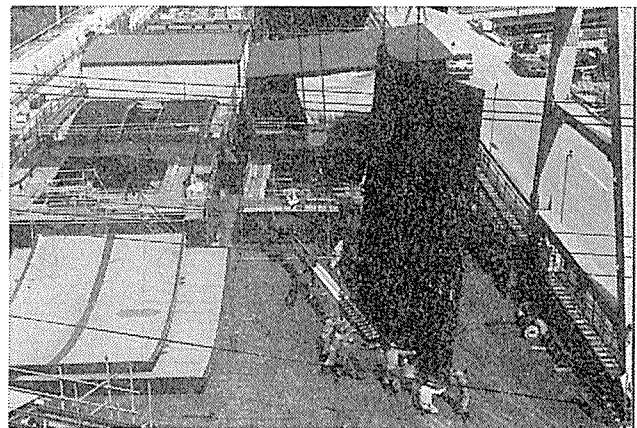
写真-3 仮工場での大ブロック化
