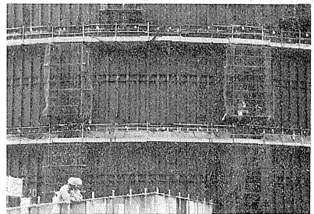
写真—9— ライナ外部足場
