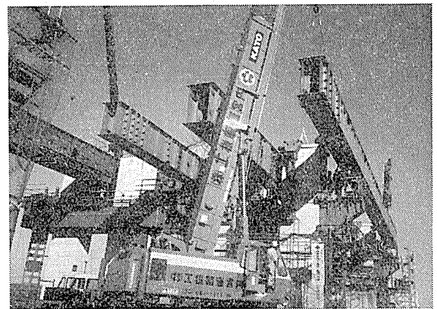
写真-5 上り線可動支保工の組立
