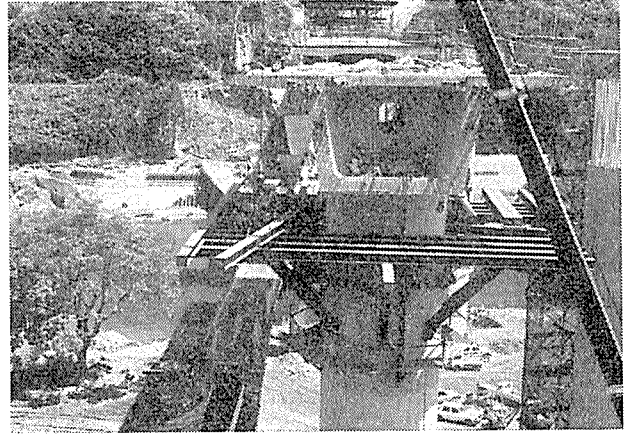
写真-4 柱頭部支保工の解体 (P 4 )
