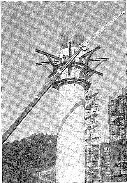
写真-3 柱頭部ブラケットの取付け (P 3 )
