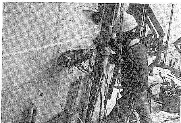
写真-10 円周方向 PC 鋼棒緊張状況
