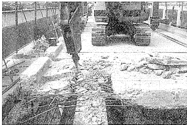
写真一6 ブレーカーによる鋼桁上床版はつり
