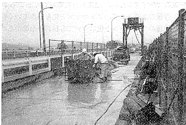
写真一5 コンクリートカッターによる床版切断
