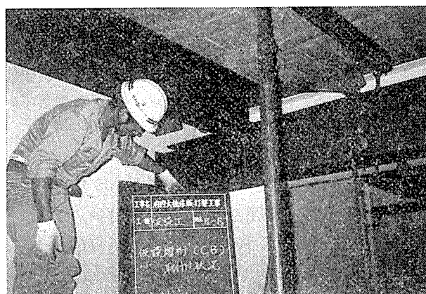
写真—3 床版仮受け用仮設増桁取付け
