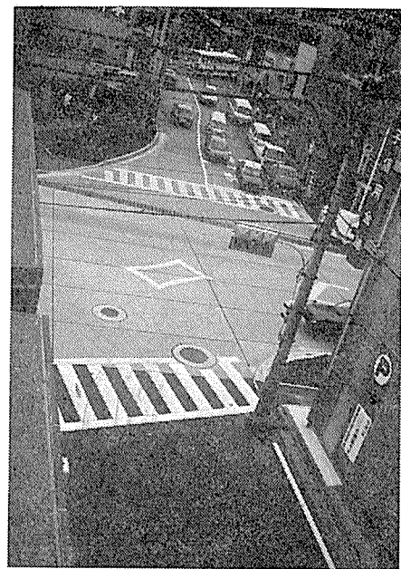
写真二 高尾駅前交差点プレキャスト PC 版舗装
