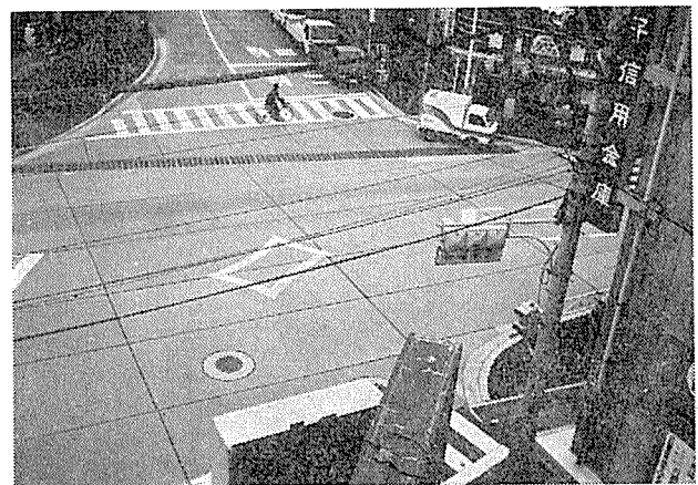
写真—7 完成時の状況
