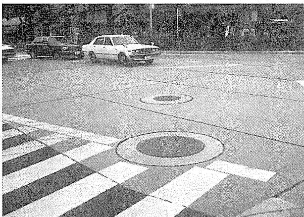
写真-1 完成後の交差点の一部
