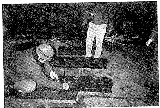
写真—4 段差調整
