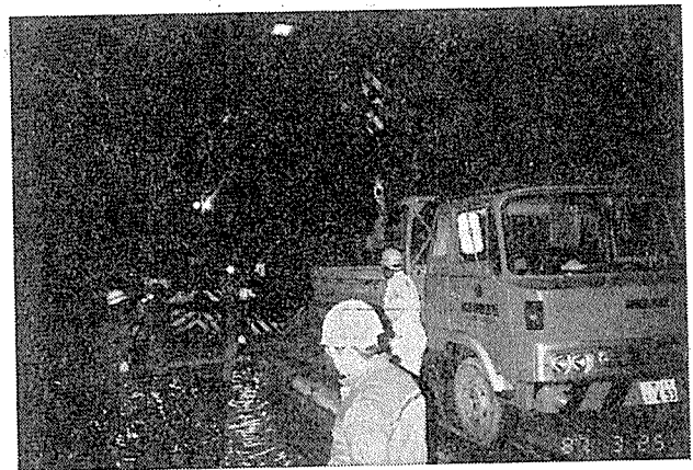
写真—3 PC 版敷設
