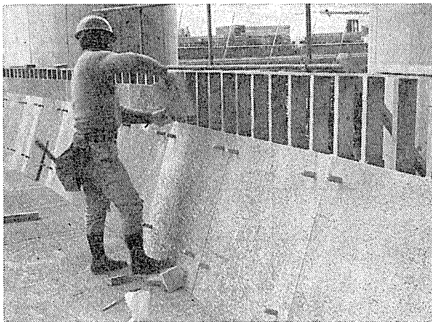
写真—9 防食パネル施工
