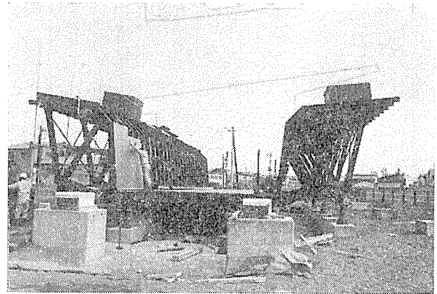
写真-5 主桁製作台および型枠
