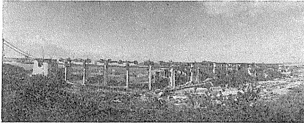
写真—3 道路桁施工中の与島高架橋
