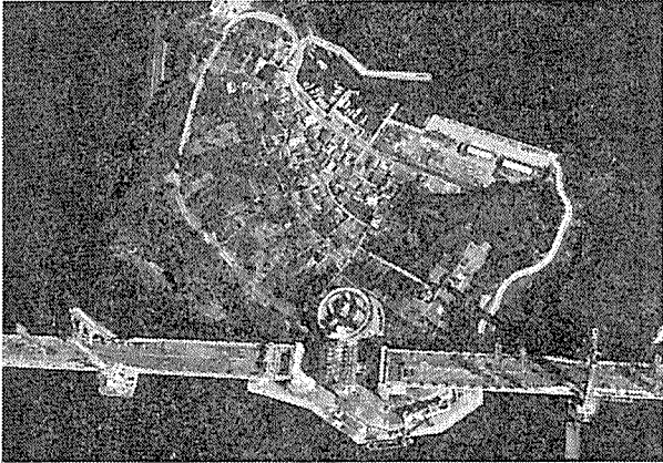
写真—1 工事全景
