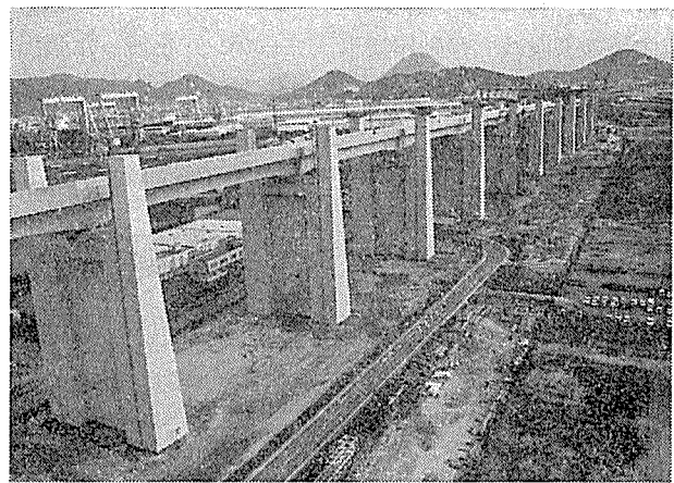
写真-1 番の州高架橋鉄道桁完成
