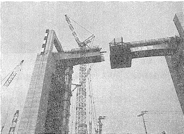
写真-3 仮支柱による張出し工法
