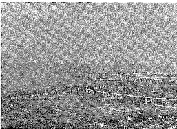
写真—1 本四備讃線全景
