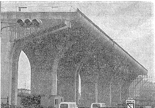
写真—3 近畿自動車道名古屋亀山線高架橋標準部
