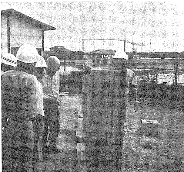
写真-6 試験施工実大モデル
