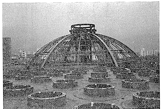
写真-2 プレキャスト PC 部材の建方時仮受け構台（遠景）
