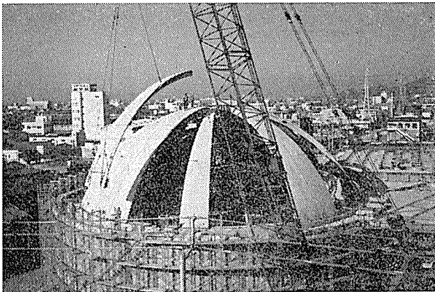
写真-4 プレキャスト PC 部材の建方状況
