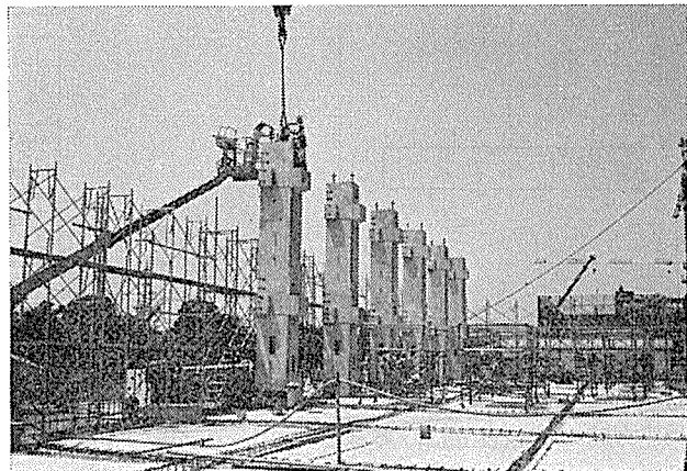
写真-3 2節柱架設
