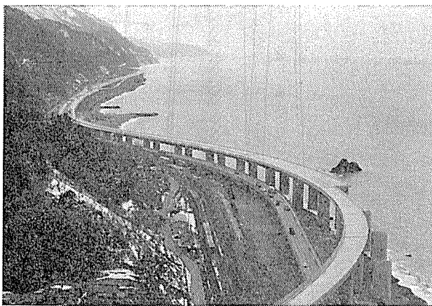
写真-1 親不知海岸高架橋
