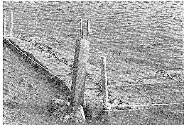
写真-3 海岸曝露の状況
