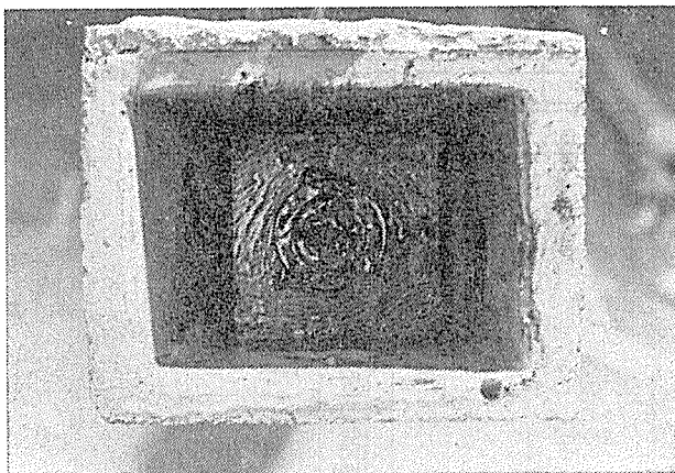
写真-2 タールエポキシによる定着部処理
