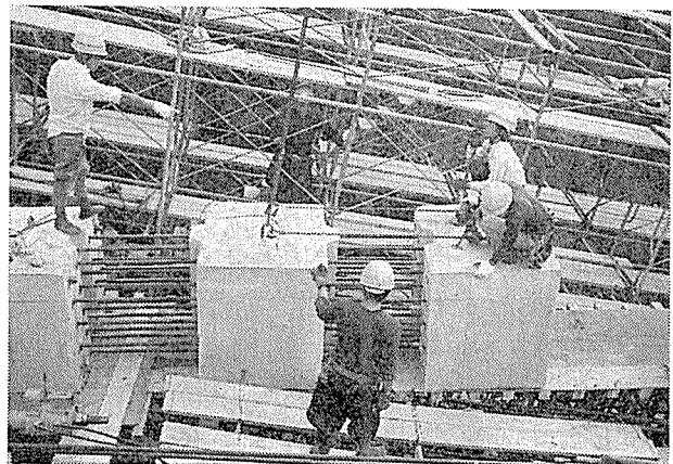
写真-3 プレキャストブロック架設状況
