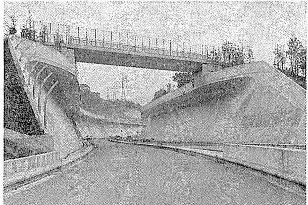
写真-2 横浜市道高速2号線もたれ擁壁
