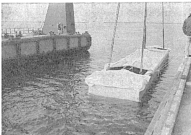
写真—3 橋体の進水状況（F.C 250 tf 吊り）
