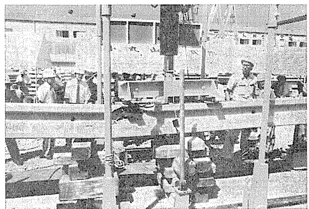
写真-4 CFRP 桁の破壊状況 (コンクリートの圧壊による)
