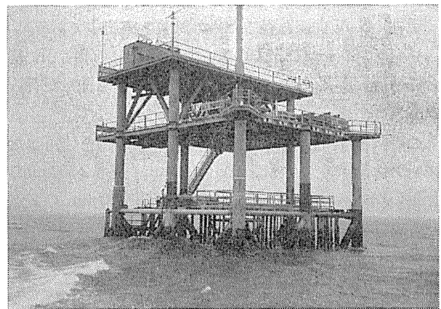
写真-3 海上曝露状況
