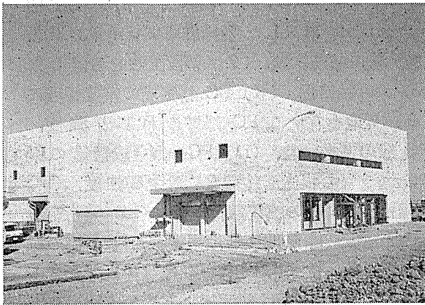
写真—1 建物の全景
