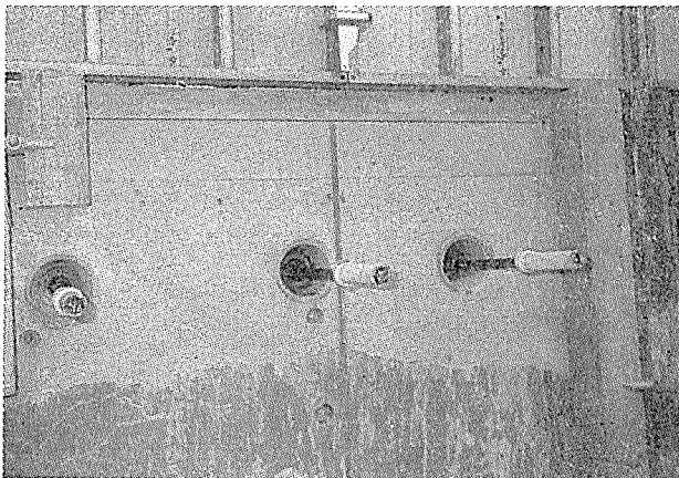
写真—7 緊張端の状況
