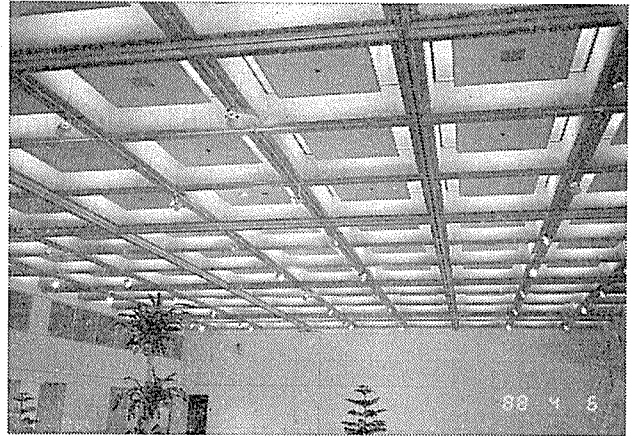
写真—2 完成状況（内観）
