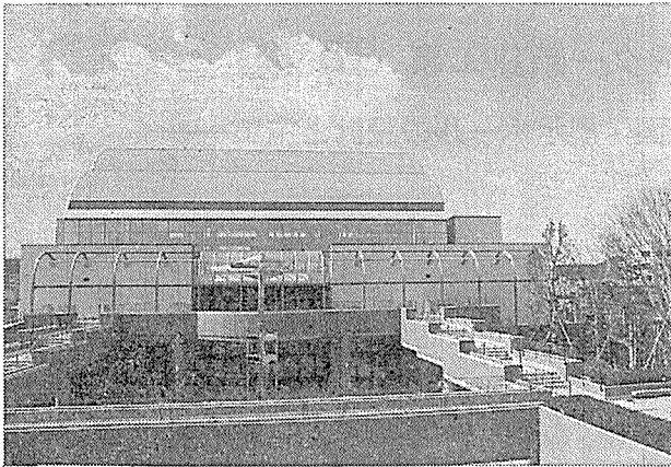
写真—1 完成状況（外観）
