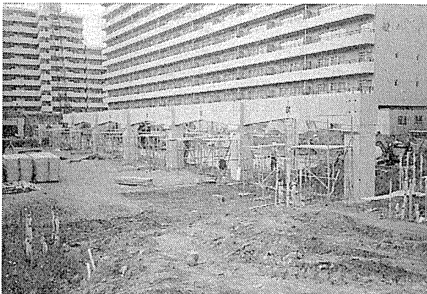
写真一八 柱・桁梁の架設
