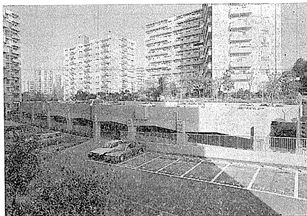
写真—3 若葉台 1-8 棟前自走式二層駐車場 (外部)
