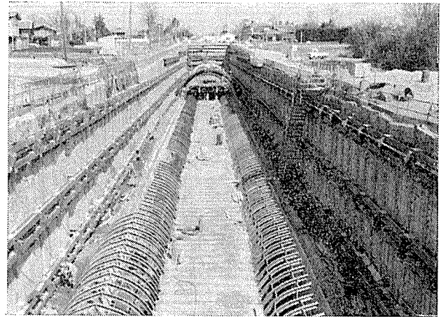
写真—5 トンネルエントランス部土留めアンカーの例
