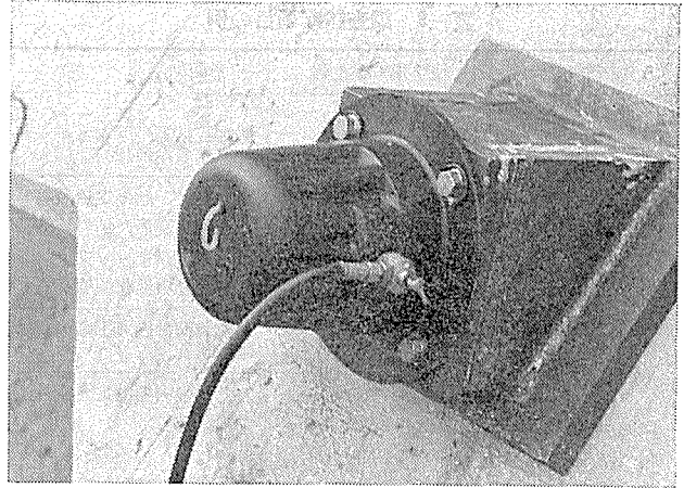
写真—3 合成樹脂製ヘッドキャップ内に防錆油を注入
